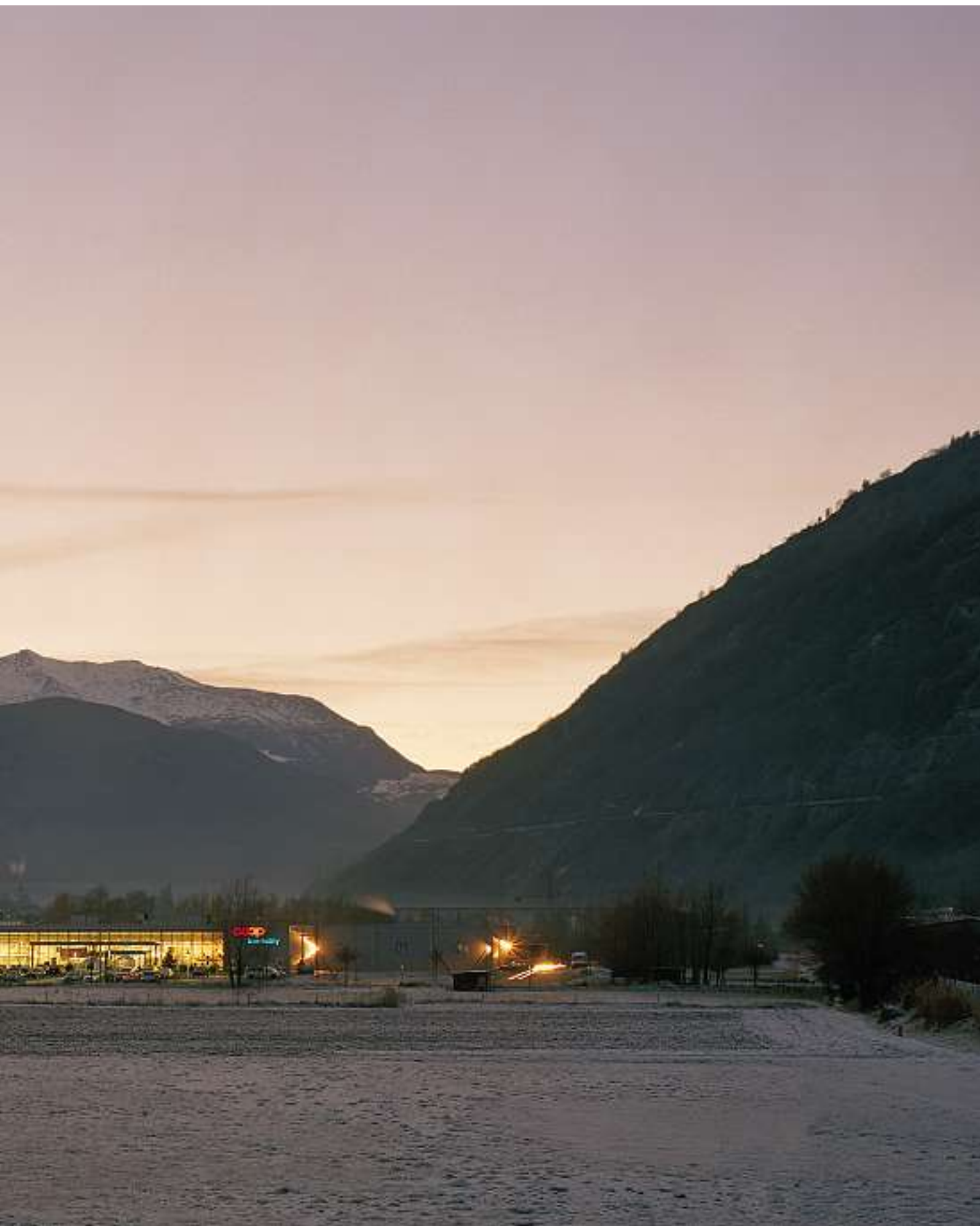
Coop Bau+Hobby Brig-Glis, Kanton Wallis, 681 Meter über Meer
